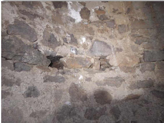
Maçonnerie du corps de la glacière et opes
