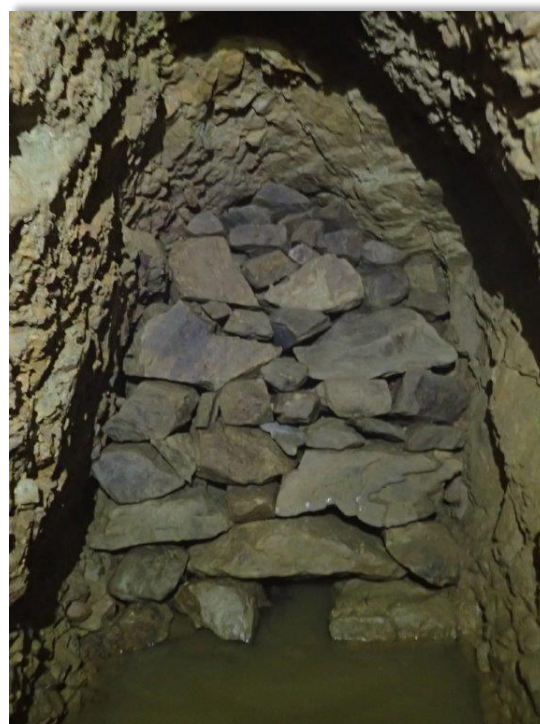
L'aqueduc et la murette d'écoulement
