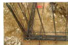
Nœud de chaînage - Continuité mécanique
