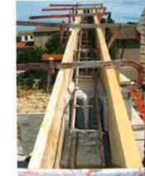
Mise en place d'un chaînage au niveau du rampant d'un bâtiment
